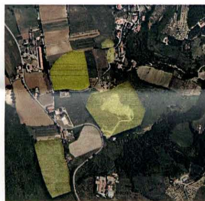
Aree con materiali di riporto.
